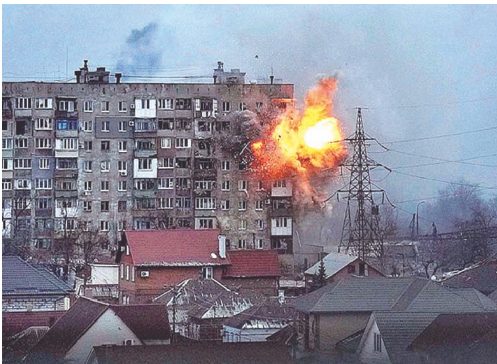
Edificio residencial bombardeado en Mariupol
